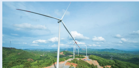
稼働する風力発電(写真:株式会社レノバ)
