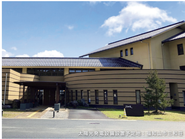
太陽光発電設備設置予定地：福知山市立桃映中学校
